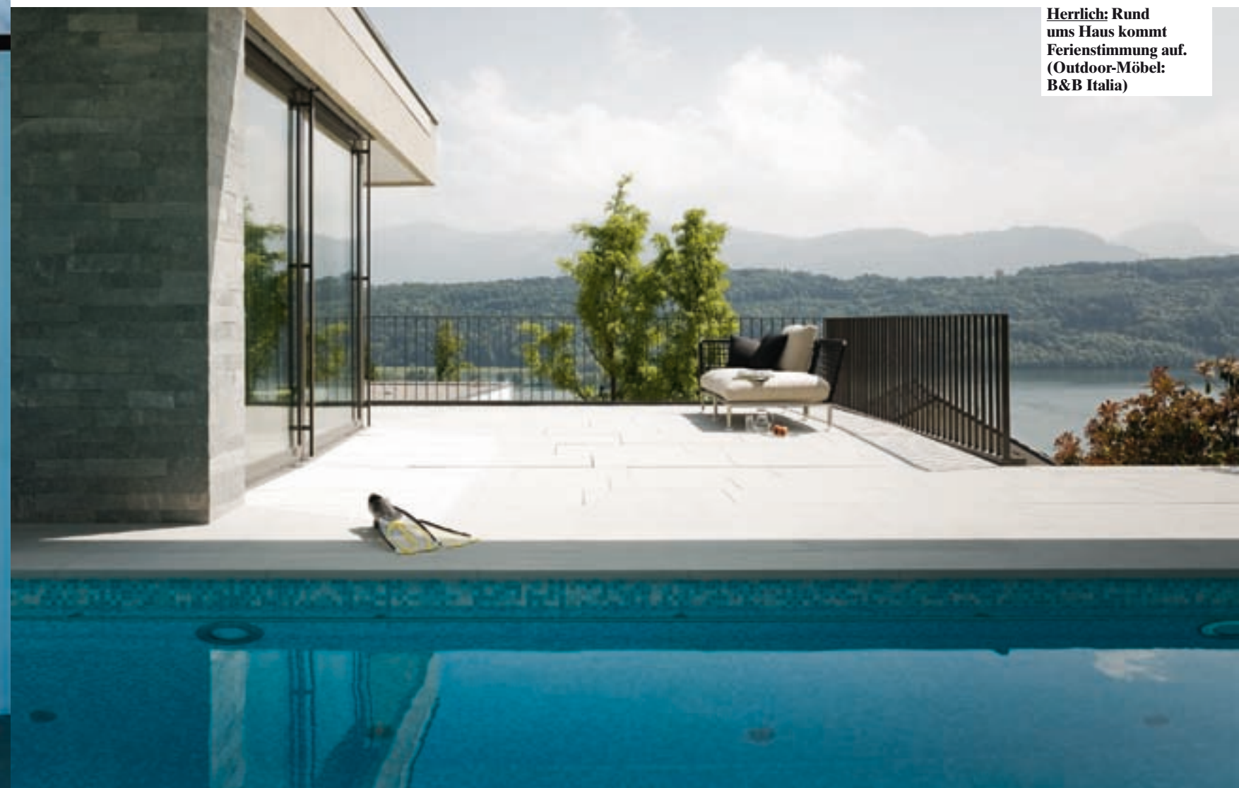
Vielschichtig: Der Baukörper mit Attikageschoss öffnet sich mit grossen Verglasungen zum See hin.
